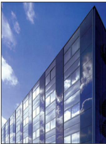
Blickfang: Die Außenansicht des Arcadia Hotels Hannover
